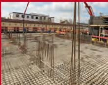
+++ DICKE DECKE FÜR MESA Am 26. März wird die 2,25 Meter dicke Decke des Forschungsneubaus für MESA betoniert. Los geht es um 4 Uhr morgens. Über den Tag hinweg fahren rund 120 Betonmischfahrzeuge vor. Am frühen Abend sind rund 1.000 Kubikmeter Beton verarbeitet, die aus 12 Metern Tiefe aufragende MESA-Halle ist jetzt geschlossen. Eine bautechnische wie logistische Meisterleistung. +++
