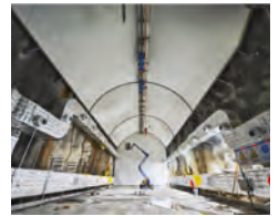
Die Halle vor dem Aufbau von JUNO
