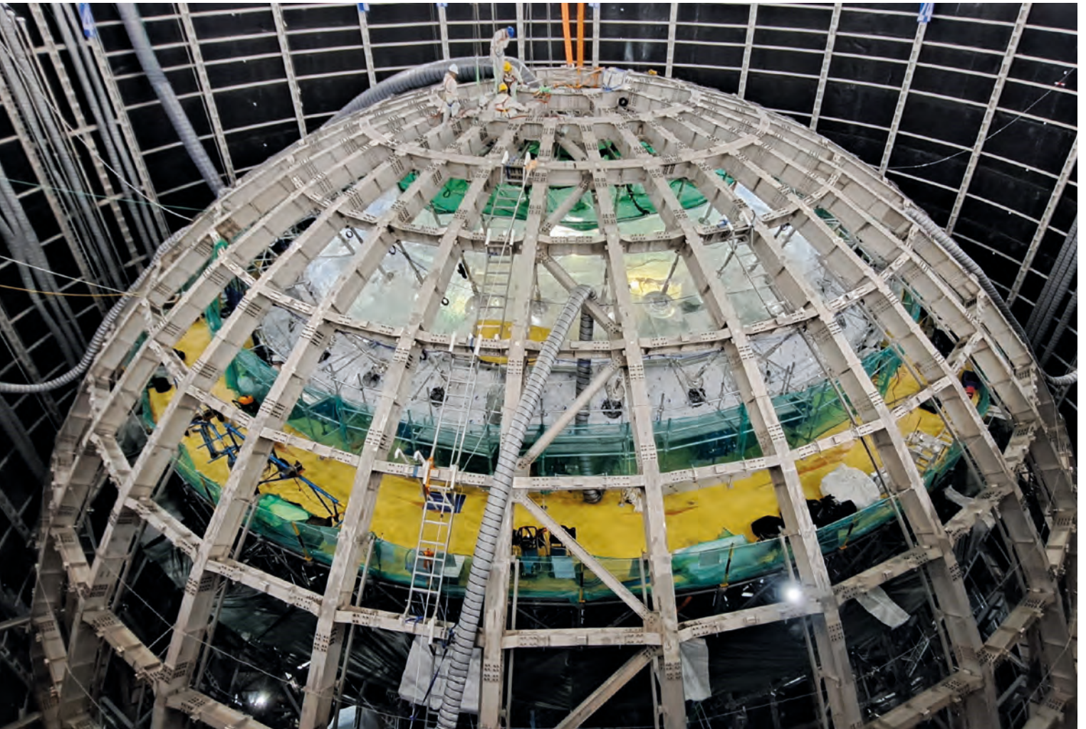
Die Plexiglaskugel des Hauptdetektors hat einen Durchmesser von 35,4 Metern und wird von einer Stahlkonstruktion mit 41 Metern Durchmesser getragen.
